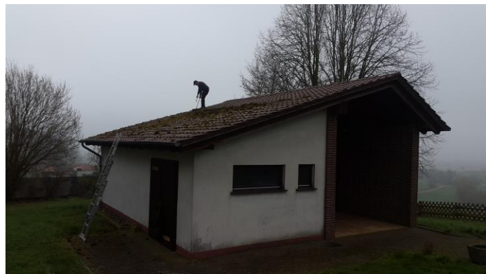
Dach der Friedhofskapelle vom Moos befreien
