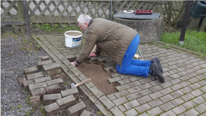
Absenkung des Pflasters auf dem Friedhof behoben
