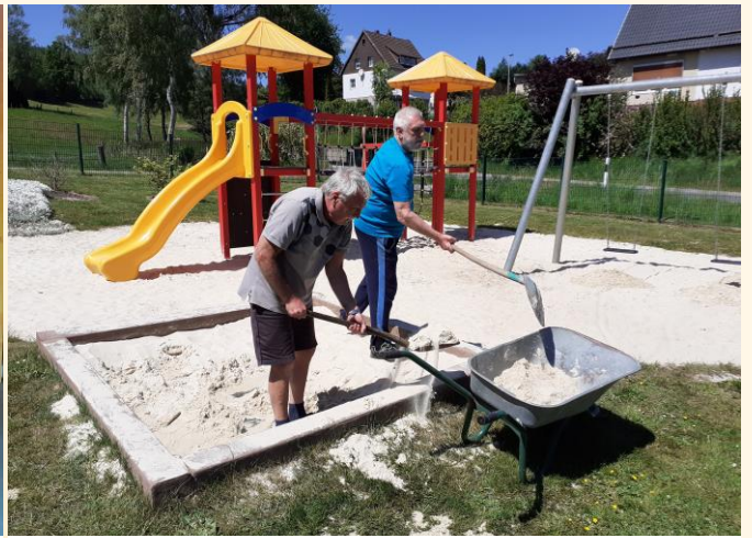
Verbringen des Sandkastensandes in den Fallschutzbereich
