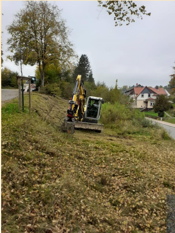
Bearbeiten der Hanglage
