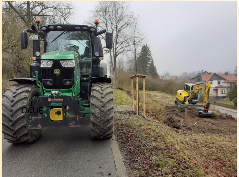
Schweres Gerät im Einsatz
