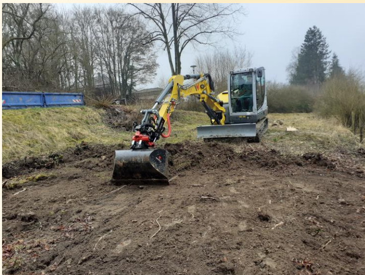
Einebnen des Geländes
