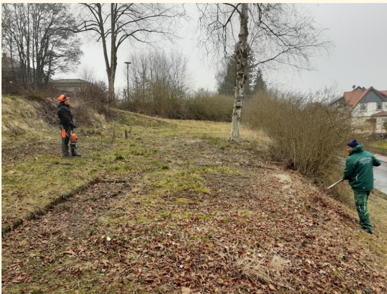
Entfernen der Heckeneinfriedung
