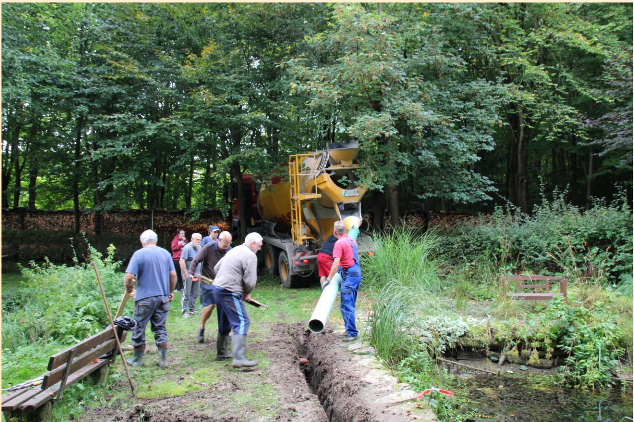
Vorbereitung zum Einfüllen des Betons
