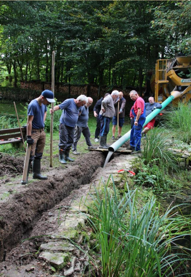
Einfüllen des Betons
