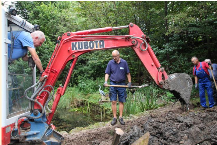
Äußerste Vorsicht bei den verlegten Rohren
