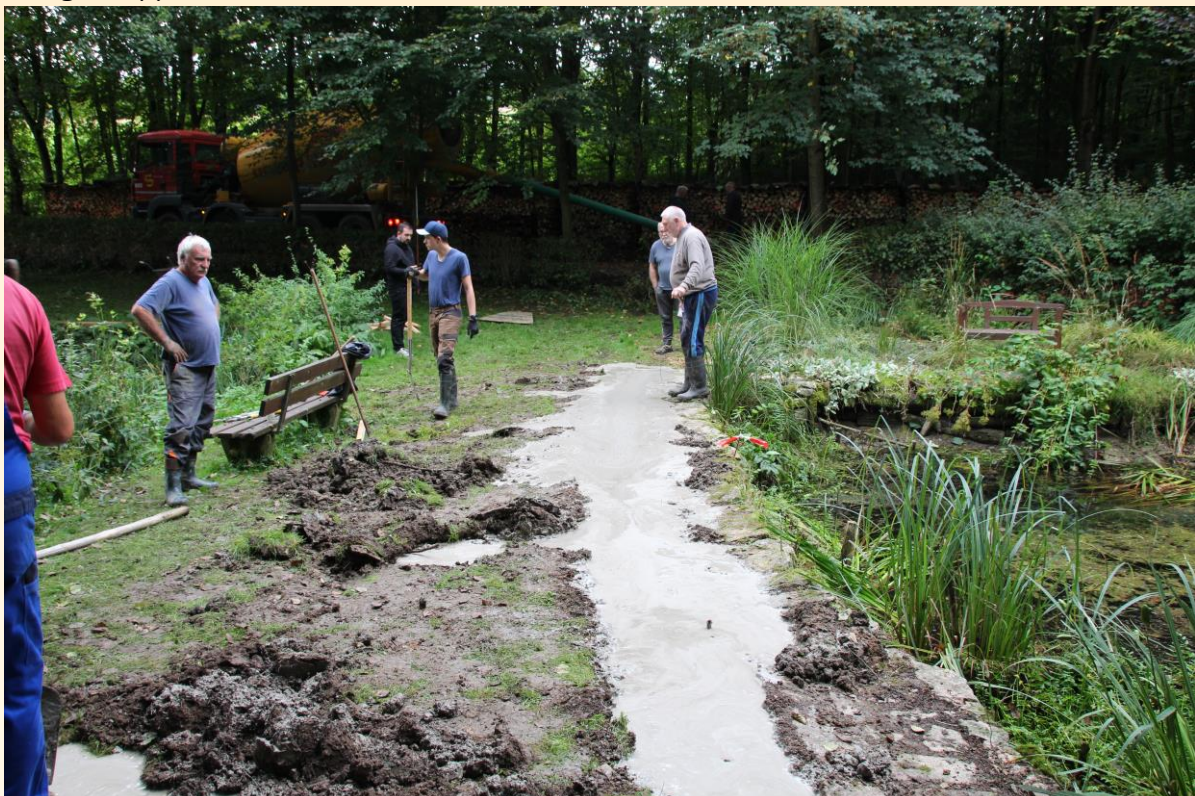
Neue Betonmauer im Zwischendamm zur Stabilisierung des Wasserverlustes OCUE/Bilder OPILI
