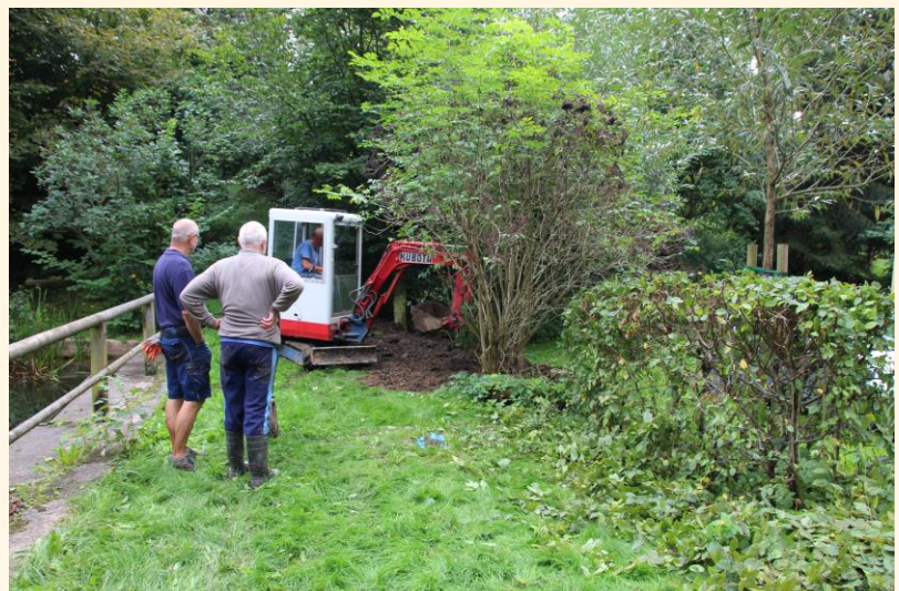
Verteilen des Bodenaushubs
