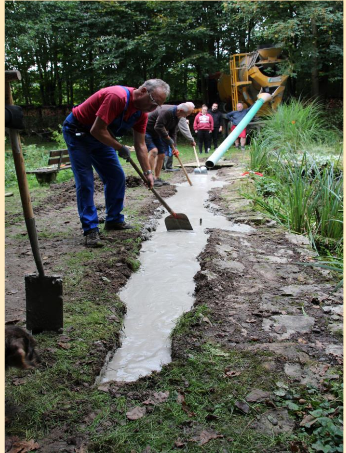
Beton im Graben gleichmäßig verteilen
